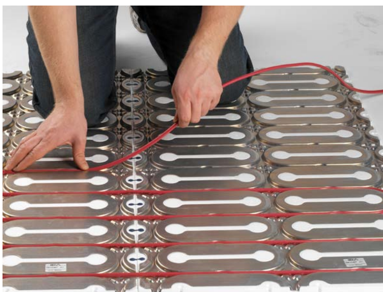
Kabeln går att förlägga smidigt i DEVlcell™ isolerskiva.
