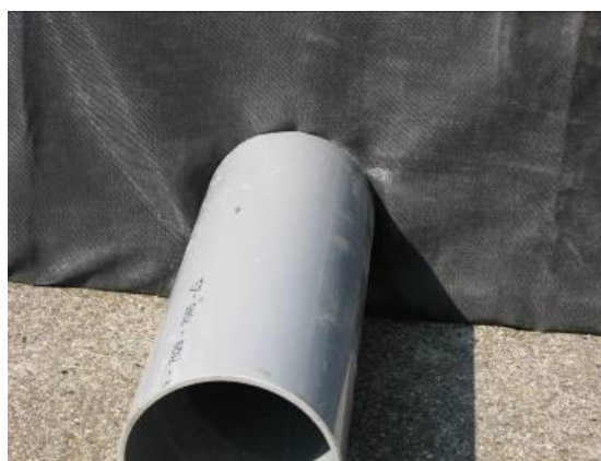
Bild 4: Koppling av rör till kassett.
