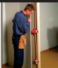
Montera gipsplattan / panelen.
